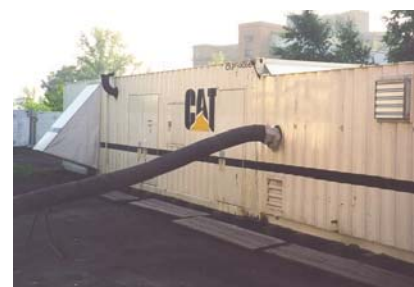
ВоркутаУголь Газовый мотор-генератор, шахтный метан, 1МВт
